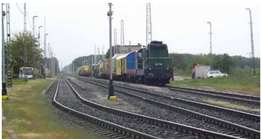
A munkagépek március óta tartózkodnak az állomáson - a képen jól láthatóak már a villanyvezeték felállított oszlopai
