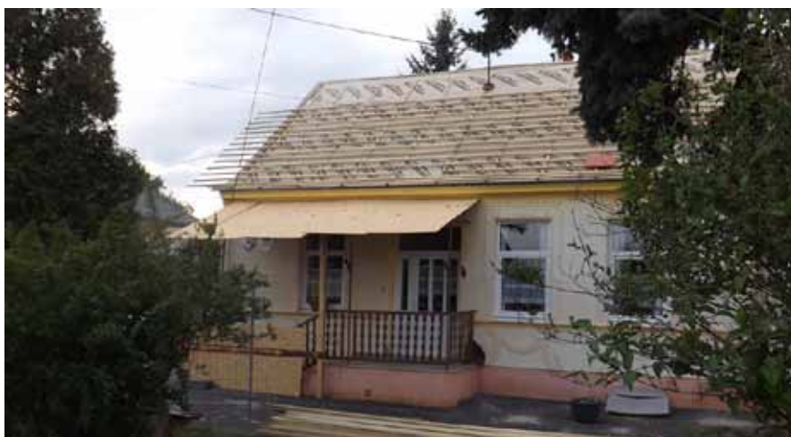
Pályázati pénzből került sor az óvoda épületének tetőcseréjére
